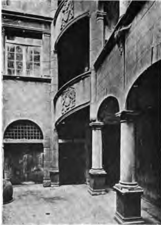
Fig. 105. — Escalier circulaire dans l'angle d'une cour de maison à Montferrand. xv e siècle. Appareillage des limons dans la grande baie éclairant l'escalier.
